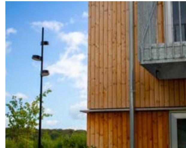
Opførelse af CLT-byggeriet Skousbo i Viby Sjælland
